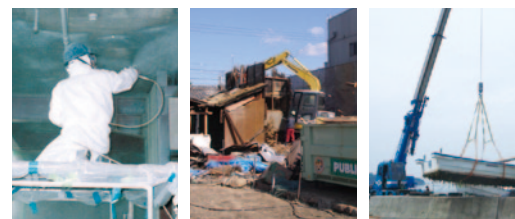
アスベスト除去作業 解体工事 廃船処理 万全な装備と、丁寧な作業で除去から処分まで安心です。 内部解体から軒丸ごとまで。迅速かつ丁寧に作業いたします。 解体から廃棄物処理まで自社対応。
