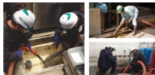
吸引清掃作業
