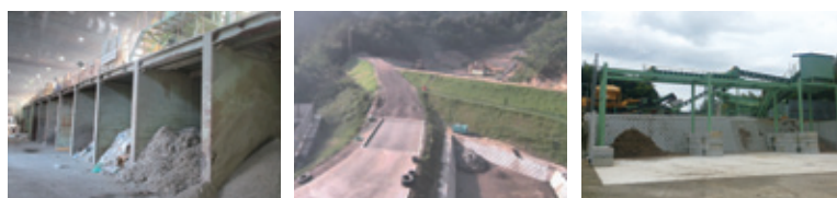
選別処理施設 最終処分場(安定型埋立地) 木くず破砕施設
