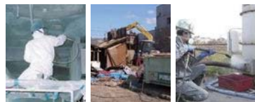
アスベスト除去作業
