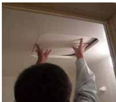
屋根裏も調査します
