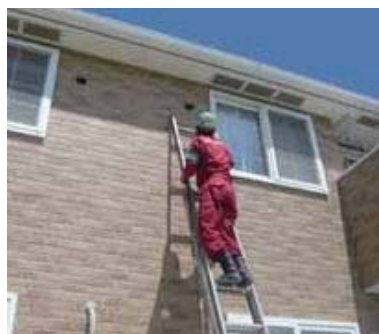
蜂の巣撤去作業
