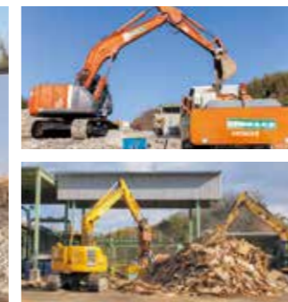
木くず破碎施設
