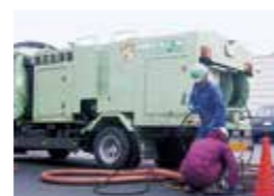
高圧洗浄作業
