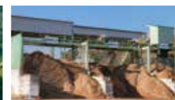
草木・木くず破砕施設
