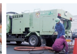
高圧洗浄作業
