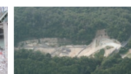
最終処分場 (安定型埋立地)
